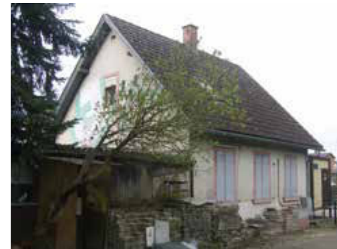
Abb. 1 Das alte Fährhaus am heutigen Campingplatz ist das einzige Gebäude Neuostheims noch aus Feudenheimer Zeit und steht unter Denkmalschutz.
